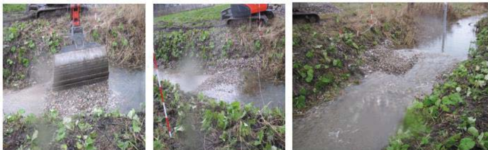
Figur 23: Som afslutning på forsøgsdagen blev der opbygget en dæmning.
