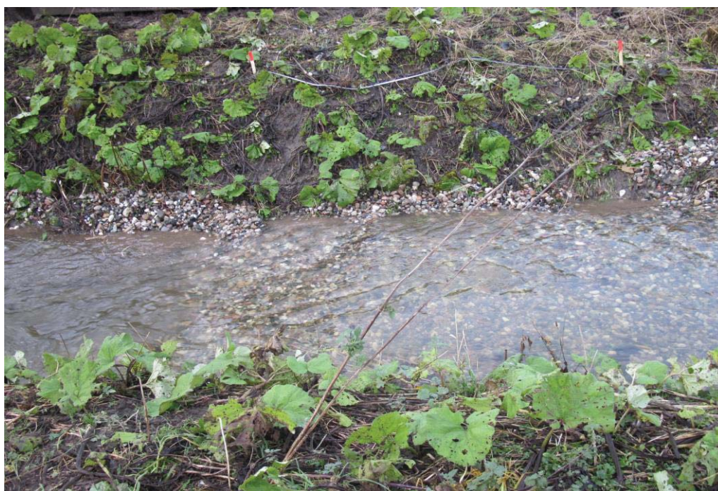
Figur 13: Bundhævning i 2, 5 og 10 meters længde. De nye profiler opmåles og der registreres vandstande ved de 6 skalapæle ved de forskellige længder af bundhævningen
