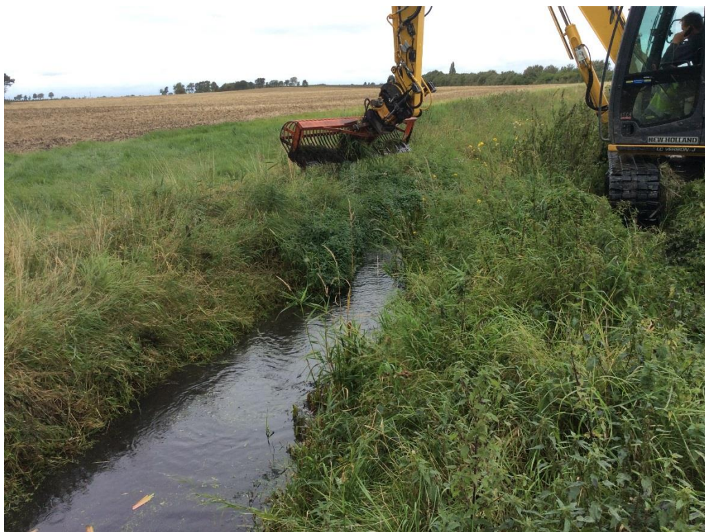
Figur 6.13. Forsøgsstrækningen i forbindelse med anden grødeskæring den 17. september 2015.
