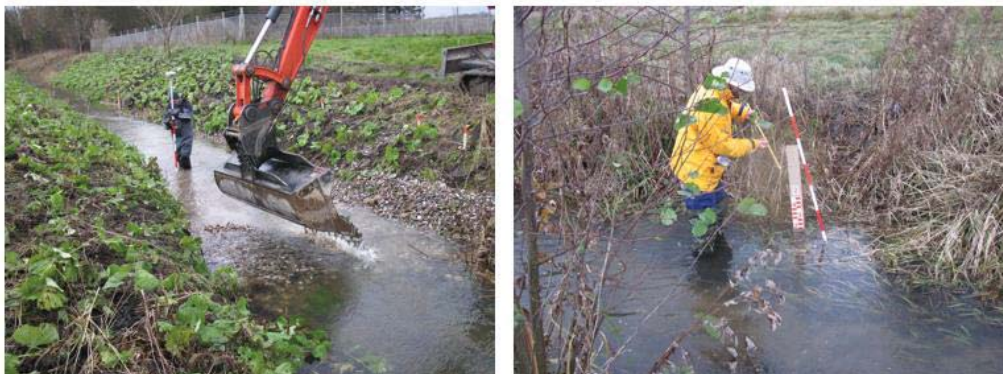
Figur 15: Stryget er ved at blive opbygget. Der blev målt op og registreret vandstande.
